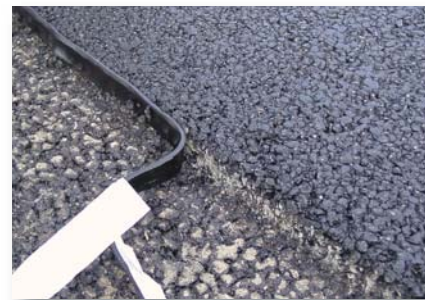
Dunaflex 30 × 8 mm-es szalag beépítése
